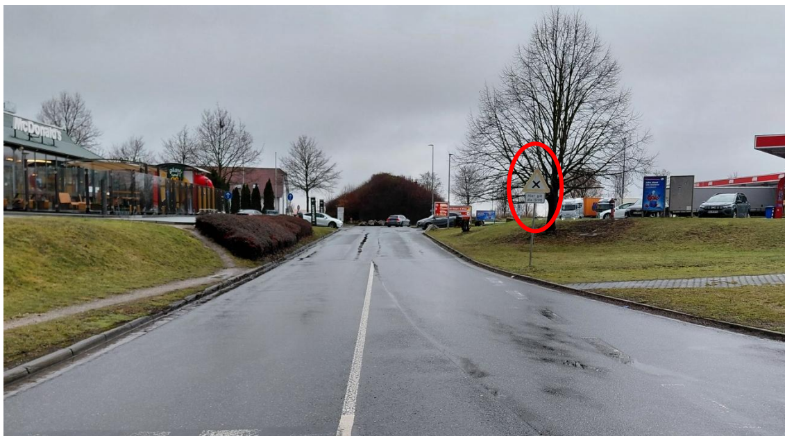
Straße Am Zainer Berg (Erschließung Autohof) mit Hinweis auf die Rechts-vor-Links-Regelung
