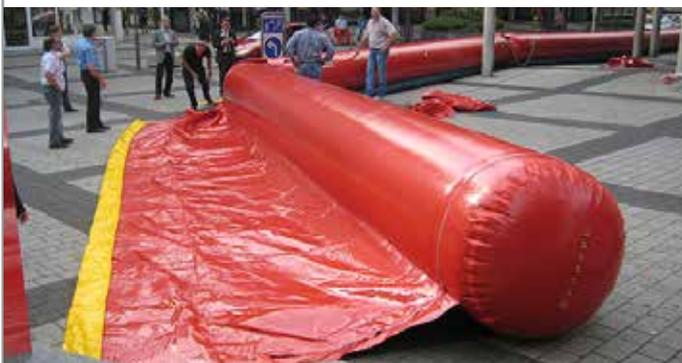
Die Stadt Seesen hat zwei mobile Hochwasserschutz-Schläuche angeschafft. Der Schlauchwall mit einer Stauhöhe von 75 cm ist außerordentlich leicht und handlich; der Aufbau geht blitzschnell. Fünf bis sechs Personen können in ca. 20 Minuten die angeschafften Elemente des Walls errichten. Insgesamt kann so ein Schlauchwall von bis zu 30 m aufgestellt werden.
